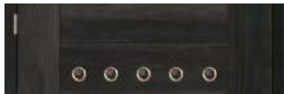
DECUPAJE DE VENTILAȚIE
